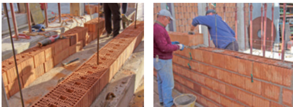
Fig. 2 - Fasi realizzative della tamponatura armata.
