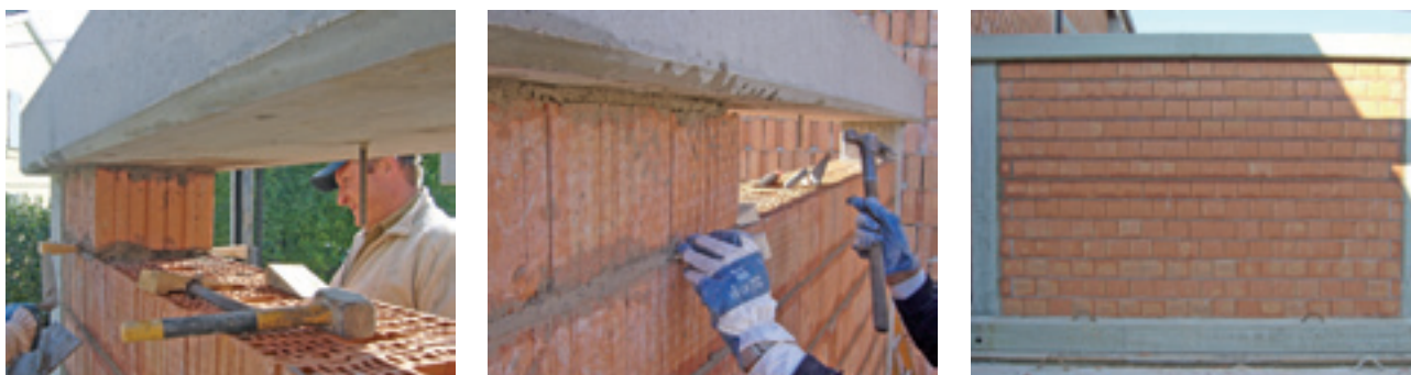
Fig. 3 - Posa dell'ultimo corso di blocchi (prima, seconda immagine) e tamponatura antiespulsione conclusa (terza immagine).
